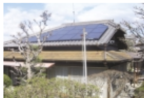
I発電所 2.27kw
