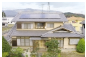
N発電所 3.67kw
