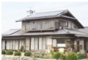
T発電所 4.13kw
