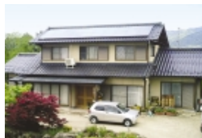
S発電所 3.10kw
