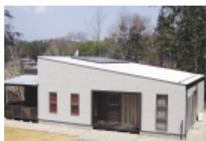
O発電所 2.75kw
