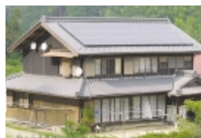
O発電所 5.18kw
