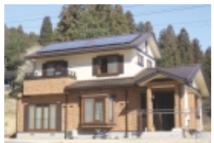
T発電所 3.29kw
