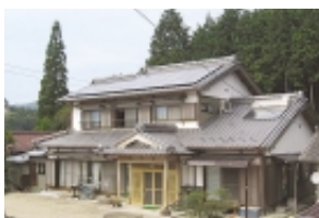
O発電所 4.08kw
