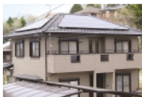
K発電所 2.70kw
