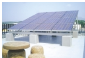
K発電所 2.51kw
